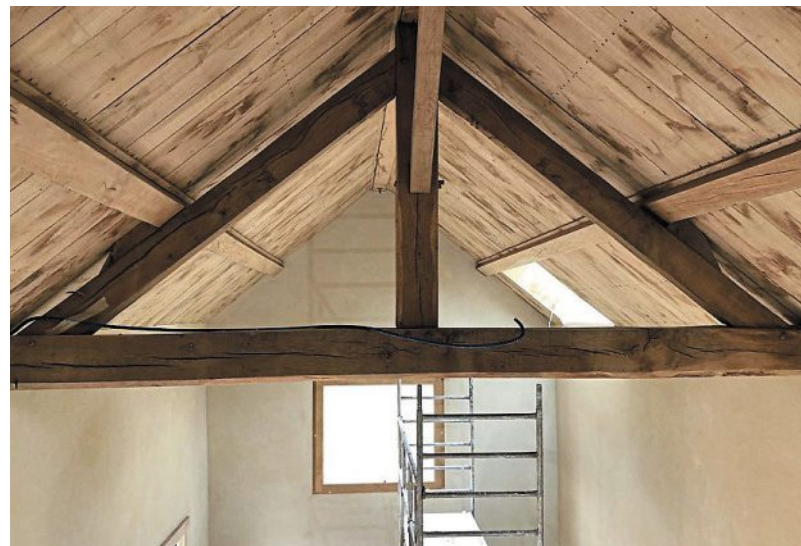
La charpente en bois a été refaite.
